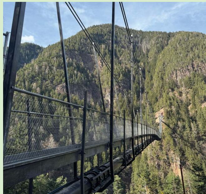
Hängebrücke Marterloch – nur Fliegen ist spektakulärer... Ponte sospeso Marterloch – solo volare è più spettacolare... Suspension bridge Marterloch – only flying is more spectacular...
